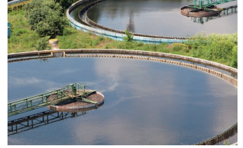
上下水処理システム
